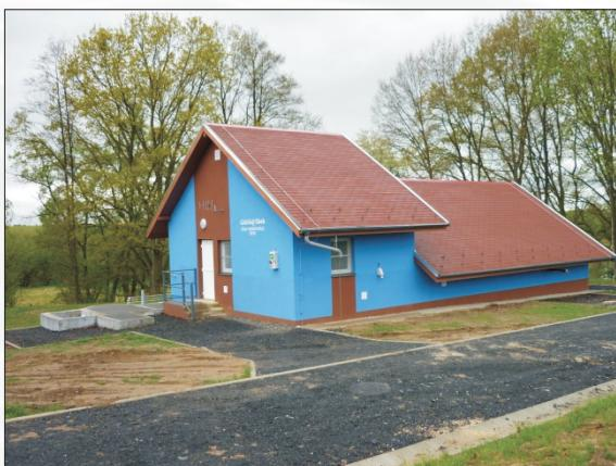
Čistírna odpadních vod Okrouhlá s návrhovou kapacitou 400 EO je součástí systému odvádění a čištění splaškových vod obce Okrouhlá u Chebu.
