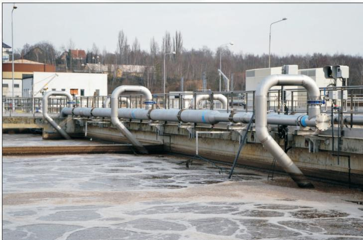
Rekonstrukce čistírny odpadních vod Plzeň s návrhovou kapacitou 427.917 EO byla realizována v rámci projektu Čistá Berounka etapa II., část A. Splnění požadovaných emisních limitů si vyžádalo optimalizaci stávajícího biologického stupně, který má rozhodující vliv na výslednou jakost vycištěné vody. Intenzifikace byla zaměřena především na zvýšení účinnosti odstranění dusíku a stabilizaci procesu nitrifikace při nižších teplotách odpadní vody.
